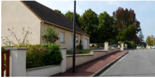
Muret béton en escalier, ponctué de piliers
