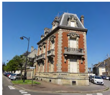
Figure 130 : Maison Bourgeoise, rue Odolant Desnos
