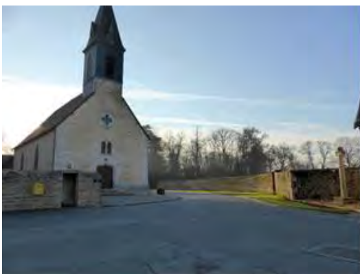
Figure 206 : Placette ouverte délimitée par des murets de pierre à Semallé
