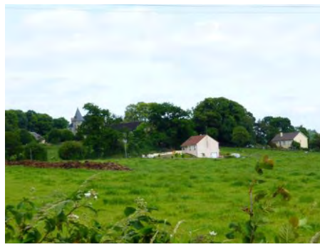
Pavillons construits en campagne, bien plus perceptibles que le hameau ancien
