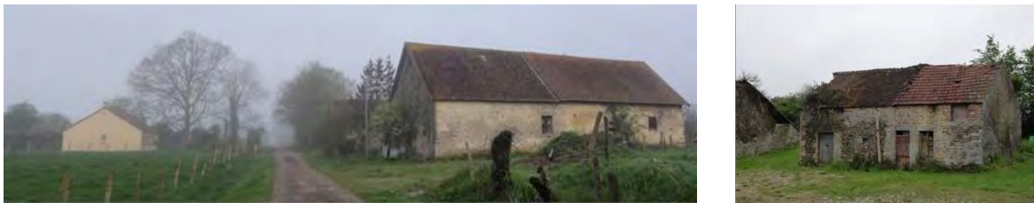
Figure 69 : Anciens bâtiments agricoles
