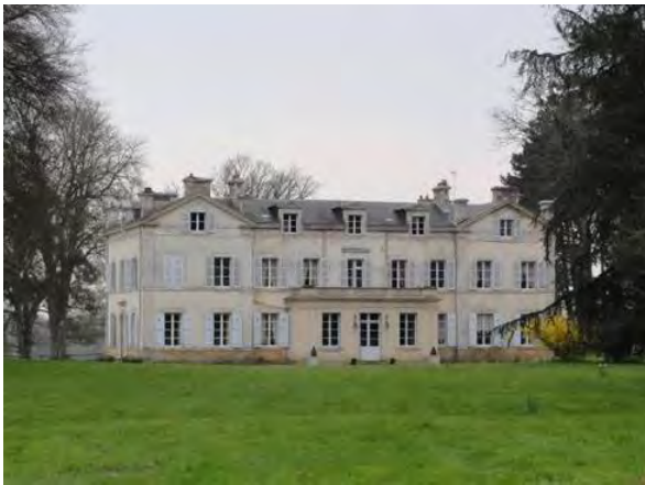
Figure 152 : Château de début XIXème siècle à Valframbert / Façade sur parc
