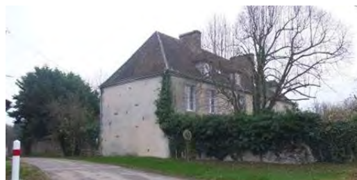
Figure 115 : Ferme manoir à Colombiers
