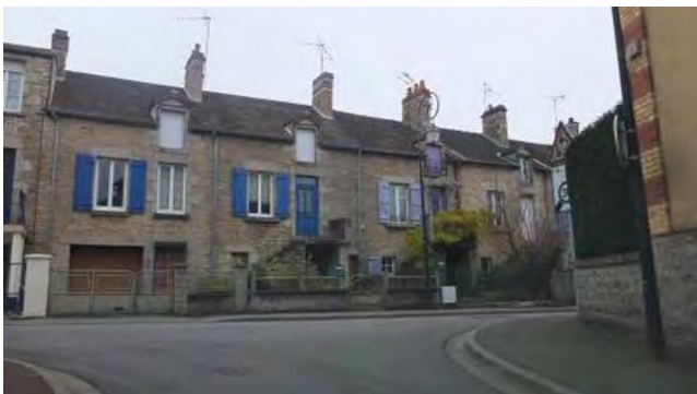
Figure 141 : Alignement de maisons de tisserands, Damigny
