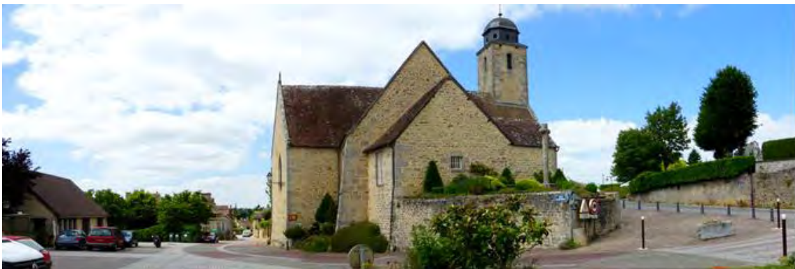
Figure 205 : Église de Condé-sur-Sarthe et ses abords
