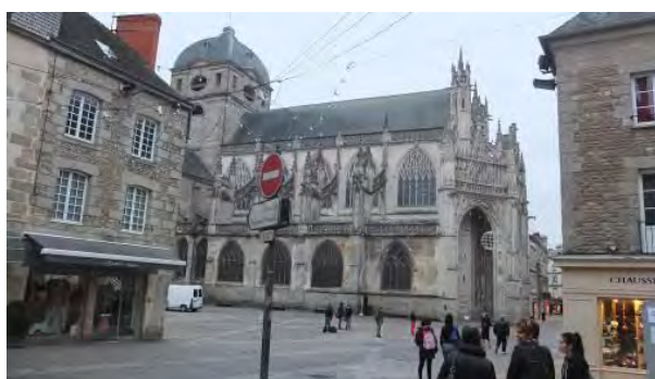
Figure 82 : Basilique Notre-Dame (début de construction XVIème siècle) MH
