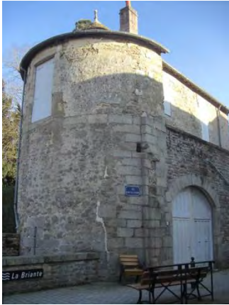
Figure 77 : Vestige de la porte de la Barre sur la troisième enceinte
