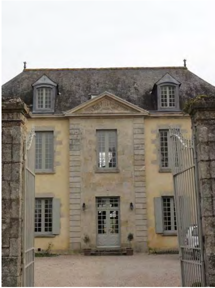
Figure 116 : Château de Cerisé, charnière entre le XVIIème et le XVIIIème siècle
