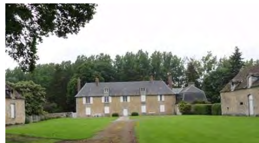
Figure 121 : Ferme de château à St-Germain du C.
