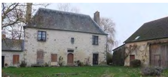
Figure 114 : Ferme manoir à Colombiers
