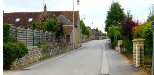
Muret en pierre dans le prolongement d'un pignon (à gauche)
