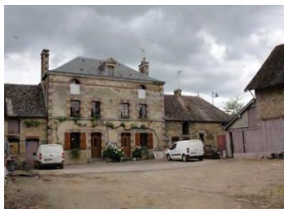
Figure 133 : Ferme moderne dans le bourg de Cuissai
