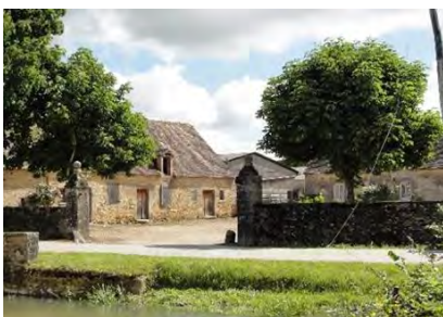
Figure 120 : Ferme du château des Vignes à Colombiers
