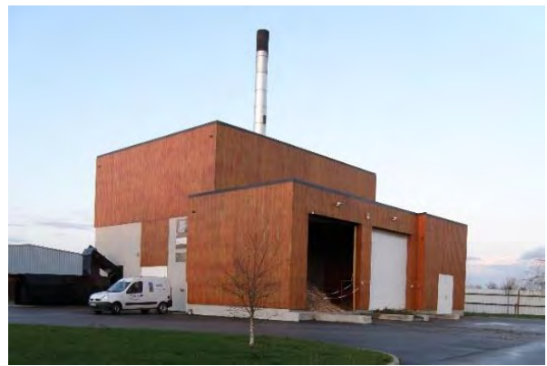
Figure 87 : Chaufferie-bois de Courteille
