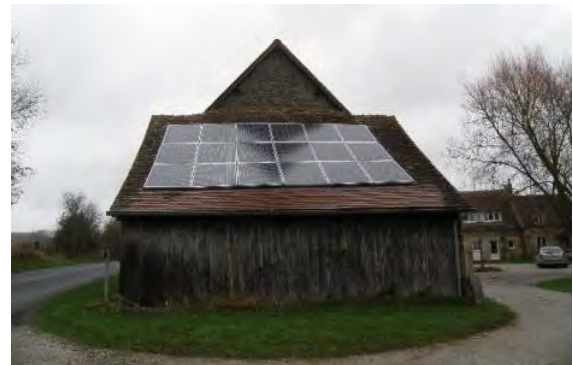
Figure 91 : Installation solaire photovoltaïque à Mieucxé
