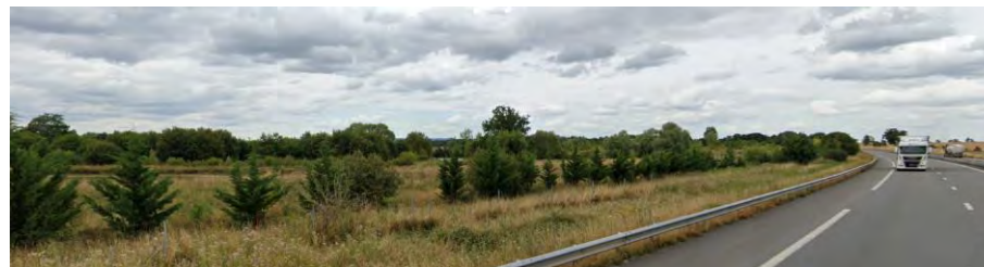
A28, direction nord d'Alençon vue de la partie sud de la zone d'étude depuis l'autoroute
