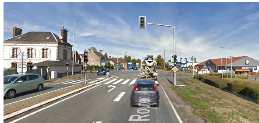
Carrefour à feux, vu dans le sens d'entrée dans l'agglomération
