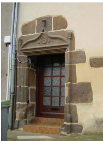
Logis début XVI e ou «Grandes maisons» à Saint-Léonard-des-Bois : porte à linteau avec «gâble en accolade» et motifs empruntés à la Renaissance, baie à linteau en accolade ayant perdu meneau et traverse, baie ayant perdu meneau et traverse, en grès roussard.
