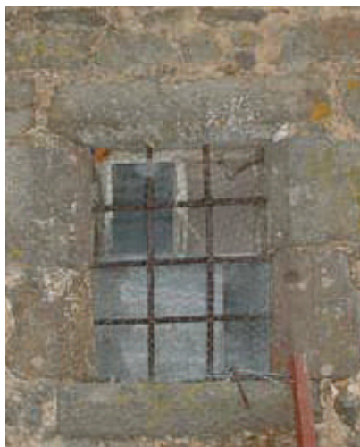
Les baies des XV et XVI ème siècle, conservent encore leurs grilles en fer forgé d'origine. Elles étaient fixées directement dans la pierre.
