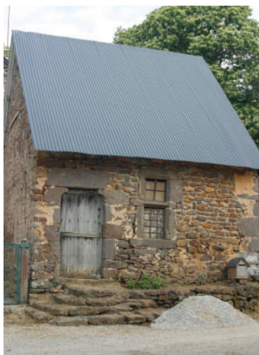
Unité d'habitation aux Cosnarderies : fenêtre à meneau en pierre avec chanfrein, grille en fer forgé.
