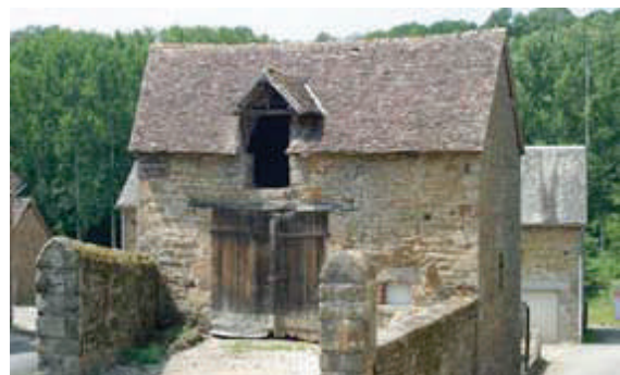
Tuiles plates, faîtage à embarrures.
