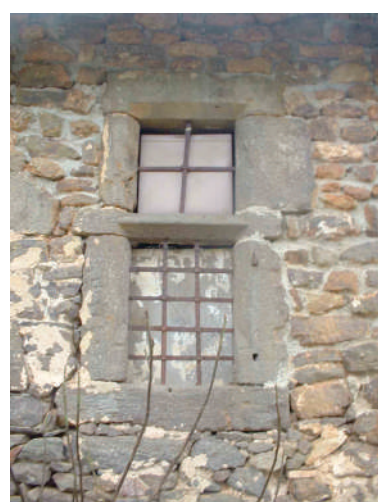
Unité d'habitation aux Cosnarderies : fenêtre à meneau en pierre avec chanfrein, grille en fer forgé.
