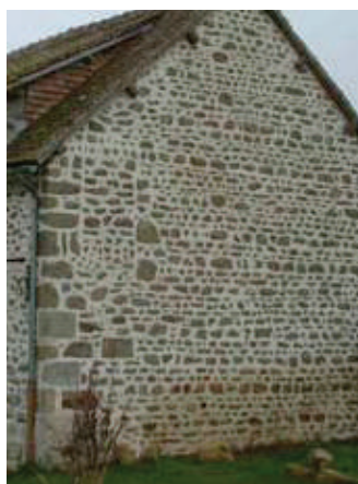
L'enduit n'est plus «à pierres devinées» tant il est clair, contrastant avec la couleur des pierres naturelles.
