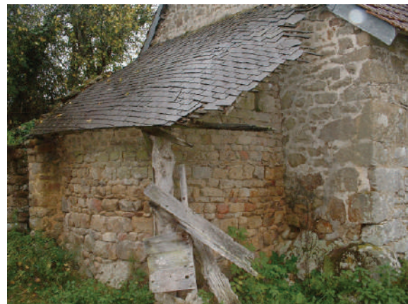
Ancien four à pain, couvert en ardoises - La Gueurie (site n°21), Saint-Pierre-des-Nids
