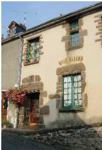
Habitation nommée logis de Claude Hardaz de Linthe - Les encadrements des baies à traverse et meneau (disparu) sont en grès roussard. Le fenestron a conservé la grille en fer forgé d'origine.
