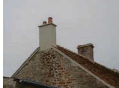
Souche dans le prolongement du pignon, enduite avec un couronnement ciment
