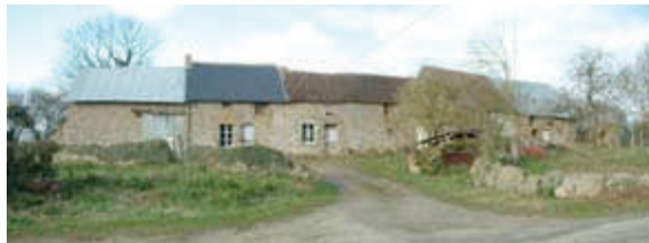
1- Exemple d'organisation du bâti en «longères» : les dépendances de types étable et grange se juxtaposent aux cellules d'habitation.
