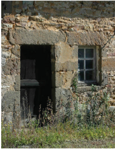
Portes et fenêtres à linteau droit, avec ou sans arc de décharge. Menuiseries d'origine : portes à husset, et fenêtres XIX e à un battant de six carreaux
