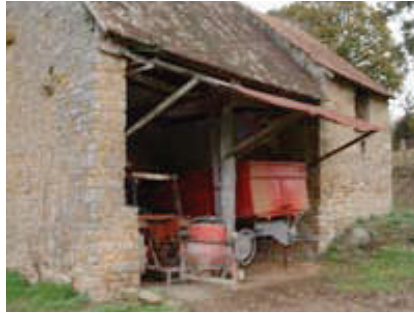
Prolongation de toiture à l'aplomb de portes cochères
