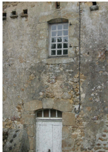
Portes et fenêtres XVIII e : baie à linteau droit, baie à faux-cintre Menuiseries d'origine XVIII e : fenêtres à petits bois, porte à panneaux et imposte vitrée
