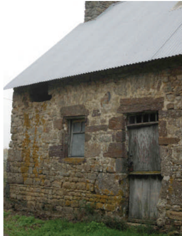
Portes et fenêtres à linteau droit, avec ou sans arc de décharge. Menuiseries d'origine : portes à husset, et fenêtres XIX e à un battant de six carreaux
