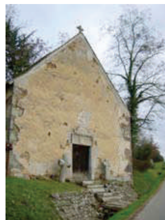
Deux exemples d'enduit «plein» sur des maçonneries anciennes, arrivant au nu des pierres d'encadrement. Les enduits sont aux tons et à la granulométrie des sables naturels non tamisés, en parfaite harmonie avec la pierre locale.
