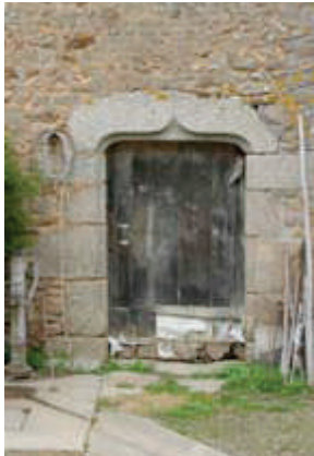
Portes traditionnelles à planches verticales, assemblées à rainures et languettes. Des pentures métalliques sont fixées aux planches par des clous forgés dont la pointe est rabattue. Les portes étaient «réparées» par des entures en parties basses.
