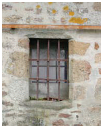
Les baies des XV et XVI ème siècle, conservent encore leurs grilles en fer forgé d'origine. Elles étaient fixées directement dans la pierre.
