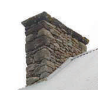
Souche en moellons de granit et grès roussard à la Buretière - Saint-léonard-des-Bois
