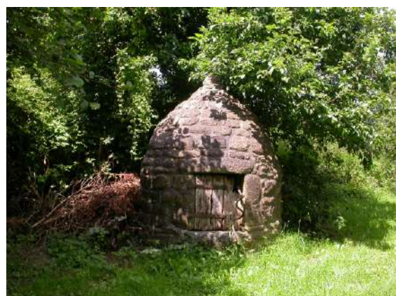
Le puits à mitre situé en extrémité sud de Champoirier
