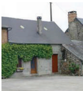
L'enduit a été réalisé au ciment, sur lequel a été redessiné un appareil de fausses pierres.
