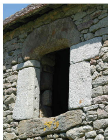
La Mière : porte chanfreinée à linteau en accolade, fenêtre chanfreinée avec l'emplacement visible des anciens barreaudages en fer forgé
