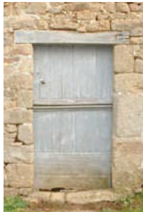
Portes de tradition rurale, s'ouvrant en deux parties, dites «à husset», permettant d'aérer sans que les animaux ne sortent ou ne rentrent.
