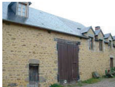
Dans un hameau, la porte cochère avec double hauteur et linteau bois peut être recrée pour un garage.
