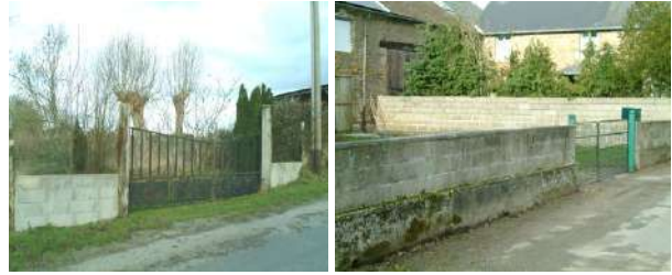
Exemples d'éléments architecturaux peu esthétiques pour le paysage de la Paire
