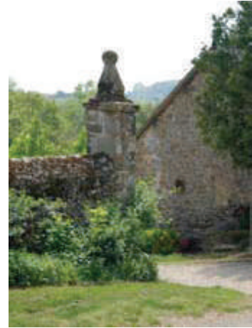
Piliers de portail différencié du mur de clôture
