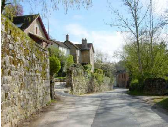
Les murs bordant la voie
