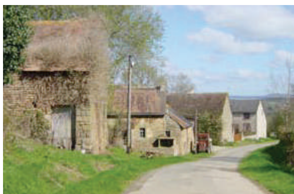
Bâti avec pignons sur la voie - les façades sont ouvertes au Sud - La Saussaie (site n°4)
