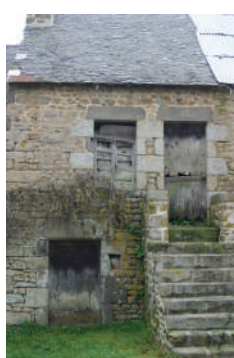
La Thibordière (site inscrit n°24), à Saint-Pierre-des-Nids, ou La Buretière à Saint-Léonard-des-Bois, l'habitation est à l'étage.
