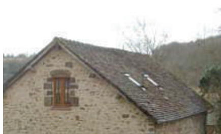
Châssis de toit encastrés : bonne intégration dans la toiture
