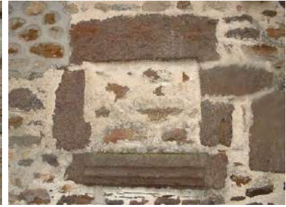
Encadrement de baie en grès roussard – La Lortière, Saint-Léonard
