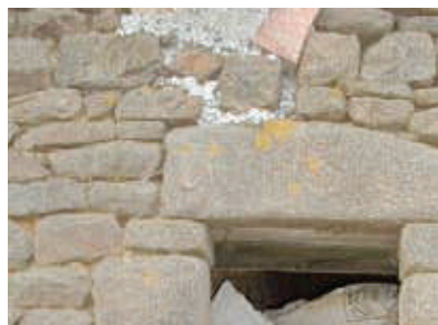
Appareillage des murs en moellons de granit - tons gris, rosé (présence de fer), parfois ocre jaune -ocre rouge à Moulins-le-Carbonnel et Saint-Pierre-des-Nids
