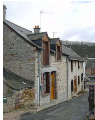
Implantation des maisons le long des chemins, perpendiculaires aux courbes de niveau – adaptation en paliers
