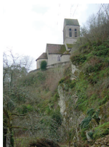
Vue du pont
