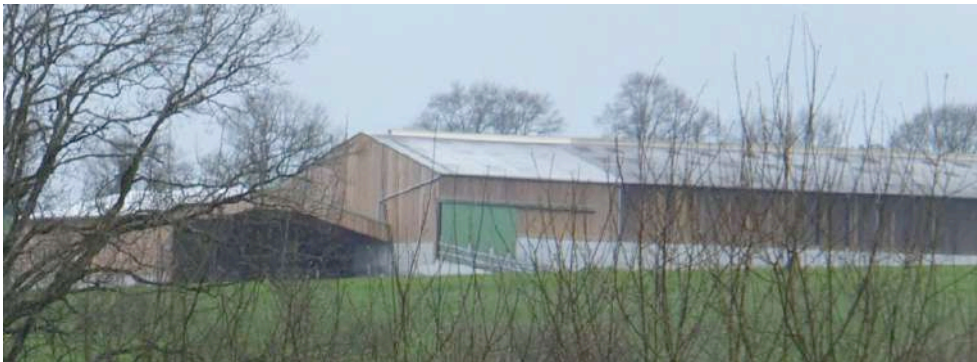
des bâtiments agricoles récents qui s'intègrent bien dans le paysage
