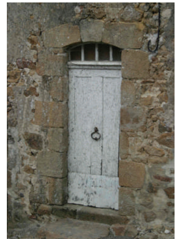
Portes et fenêtres XVIII e : baie à linteau droit, baie à faux-cintre Menuiseries d'origine XVIII e : fenêtres à petits bois, porte à panneaux et imposte vitrée
