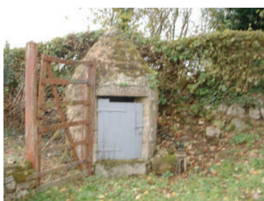
Puits au Noyer (site n°25), Saint-Pierre-des-Nids
