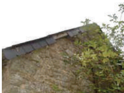
Ardoises de rive ou «bardeli» clouées sur le chevron de rive
