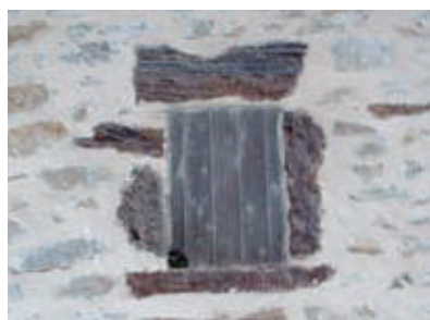
Pierres des murs de différentes natures : moellons de grès et grès Roussard pour les maçonneries ; grès Roussard ou granit pour les encadrements d'ouvertures à Saint-Léonard-des-Bois et Saint-Pierre-des-Nids
