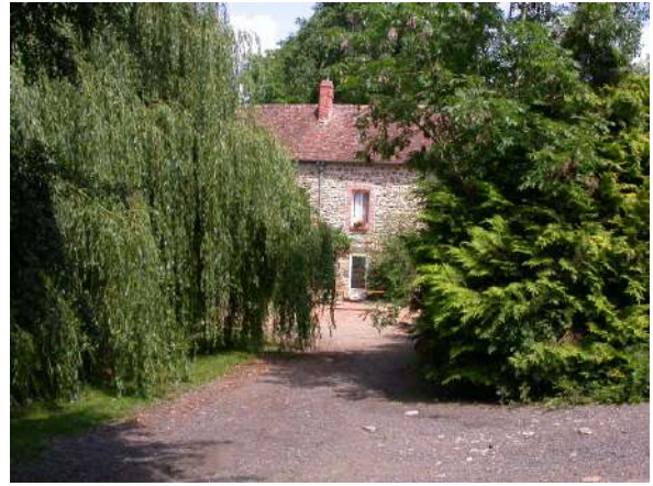
Le corps principal du moulin vu du chemin d'accès menant à la route (Rd 101 b)
