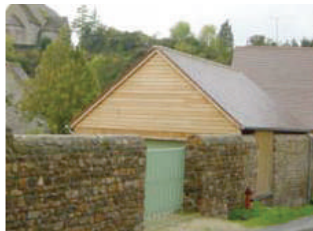
Dans un hameau, la porte cochère avec double hauteur et linteau bois peut être recrée pour un garage.
