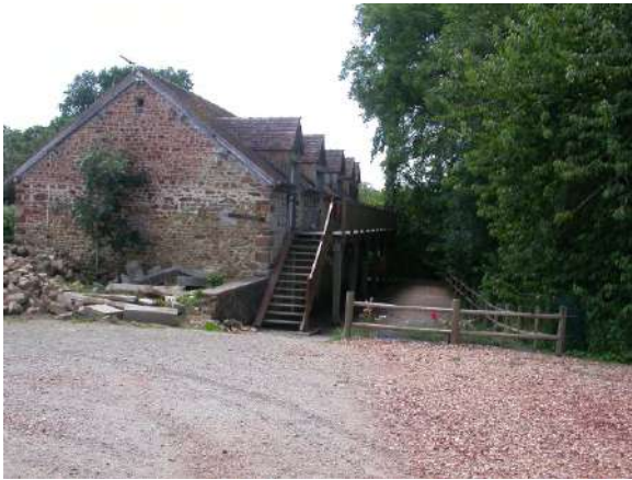
Vue de la construction située la plus à l'est
