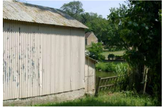
Vue sur la chapelle masquée par un garage en tôle
