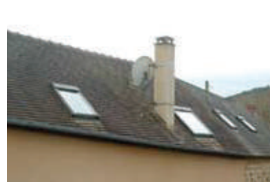
Châssis de toit non encastrés
