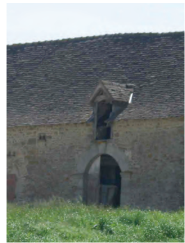
Travées du XVII e avec porte cochère cintrée et lucarne en bois
