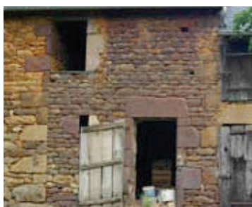
Maçonneries en moellons de grès Roussard, encadrements des ouvertures en grès Roussard - commune de Saint-Léonard-des-Bois -
