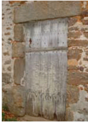
Portes traditionnelles à planches verticales, assemblées à rainures et languettes. Des pentures métalliques sont fixées aux planches par des clous forgés dont la pointe est rabattue. Les portes étaient «réparées» par des entures en parties basses.
