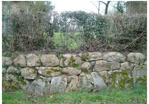
Un muret de soutènement en pierre du pays accompagné d'une haie basse
