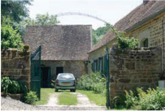
Mur avec harpage de pierres marquant l'ouverture d'un portail : deux boules en pierre terminent le pilier.
