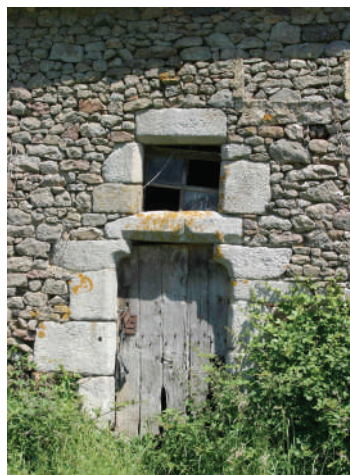
La Mière : porte chanfreinée à linteau en accolade, fenêtre chanfreinée avec l'emplacement visible des anciens barreaudages en fer forgé
