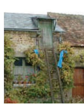
Lucarnes passantes à une pente, de proportion plus haute que large
