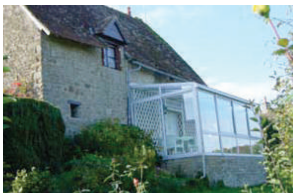
La volumétrie de cette véranda ne tient pas compte du volume principal, et les matériaux employés ne s'harmonisent pas avec la construction.
