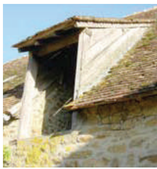
Lucarnes passantes à une pente, de proportion plus haute que large
