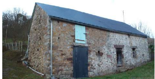
Façade sud-est d'un bâti en « longère » - partie sud-est du site
