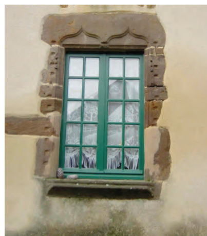
Logis début XVI e ou «Grandes maisons» à Saint-Léonard-des-Bois : porte à linteau avec «gâble en accolade» et motifs empruntés à la Renaissance, baie à linteau en accolade ayant perdu meneau et traverse, baie ayant perdu meneau et traverse, en grès roussard.
