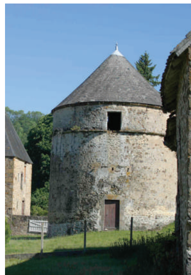
Fuie au manoir de Linthe, couverte en ardoise, Saint-Léonard-des-Bois
