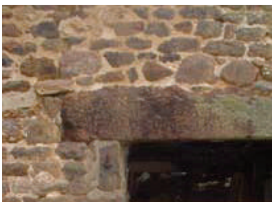
Maçonneries en moellons de grès Roussard, encadrements des ouvertures en grès Roussard - commune de Saint-Léonard-des-Bois -
