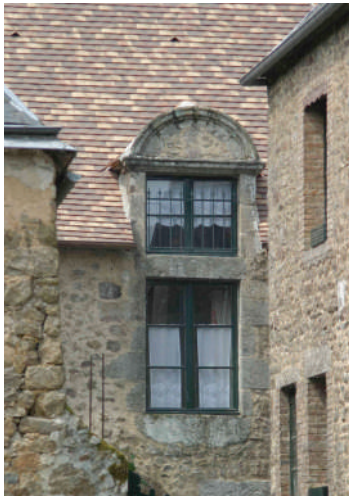
Baie surmontée d'une lucarne du XVII e à fronton cintré
