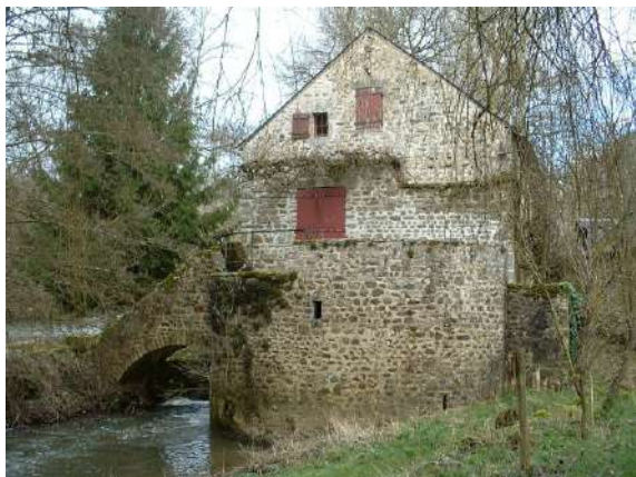
Façade sud du moulin
