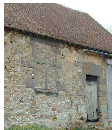
Fenêtre à meneau et traverse en pierre
