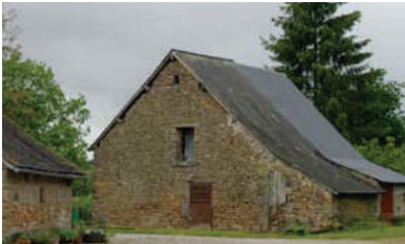
Ardoises naturelles, faîtage en lignolet.
