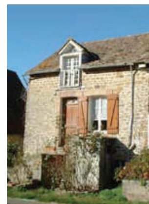
Les volets à lames étroites et écharpes en Z vus côté ouvert.
