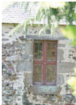
Panneaux de verres mis en plomb sur une menuiserie XVII ème siècle.
