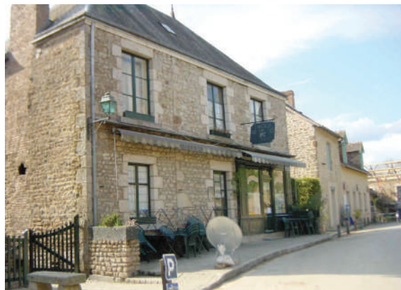
L'auberge des peintres, aujourd'hui. Un enduit recouvrait la façade à l'origine, les maçonneries de moellons n'étant pas faites pour être vues.
