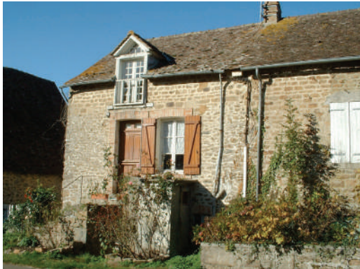
Maison de tisserand au Pont, avec l'atelier de tissage semi-enterré à la dimension du métier à tisser, et l'habitation au-dessus, accessible par un escalier en pierre.
