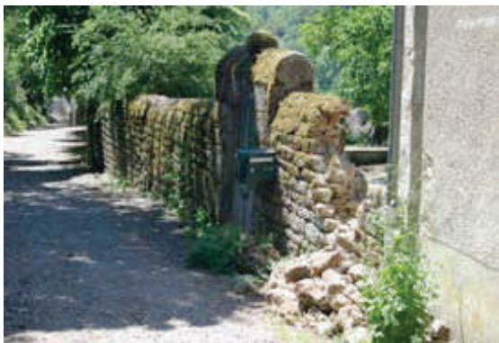
Mur avec harpage de pierres marquant l'ouverture d'un portail : un linteau est placé au-dessus du mur pour marquer le passage dans le mur.
