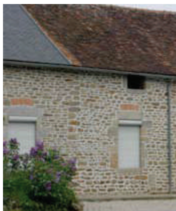
Les volets roulants en PVC posés sur des baies existantes, implique des coffres extérieurs inesthétiques. La couleur blanche est inadaptée.
