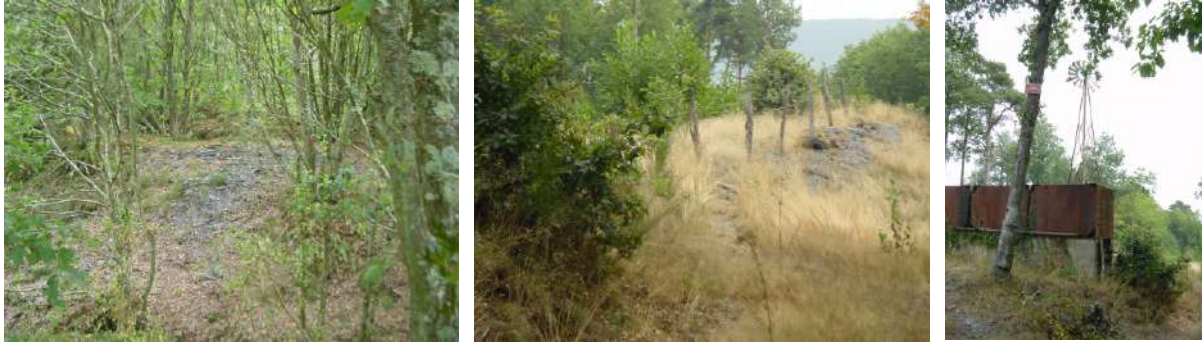
Anciennes mines d'ardoise, à l'ouest du site inscrit n°20 du Champ des Pas – Saint-Léonard-des-Bois
