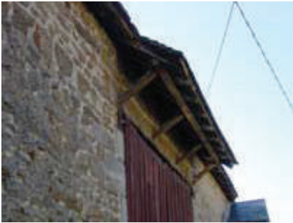
Prolongation de toiture à l'aplomb de portes cochères
