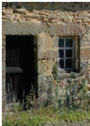
Fenêtre traditionnelle à 6 carreaux et porte à husset dans une maison rurale du XIX ème .
