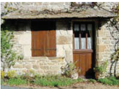
Prolongation de toiture à l'aplomb de portes cochères
