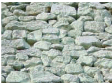
Appareillage des murs en moellons de granit - tons gris, rosé (présence de fer), parfois ocre jaune -ocre rouge à Moulins-le-Carbonnel et Saint-Pierre-des-Nids
