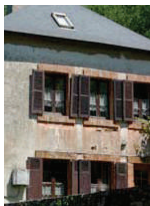
Fenêtres et persiennes XIX ème dans une maison de bourg : les lames persiennées sont présentes en partie haute uniquement pour les fenêtres du RdeC.
