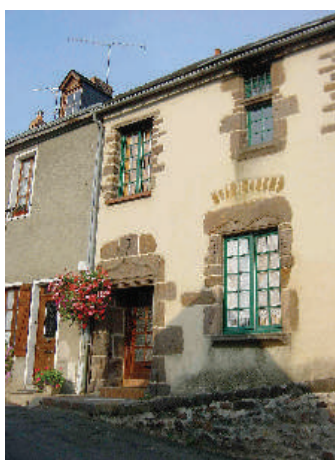
Logis début XVI e ou «Grandes maisons» à Saint-Léonard-des-Bois : porte à linteau avec «gâble en accolade» et motifs empruntés à la Renaissance, baie à linteau en accolade ayant perdu meneau et traverse, baie ayant perdu meneau et traverse, en grès roussard.
