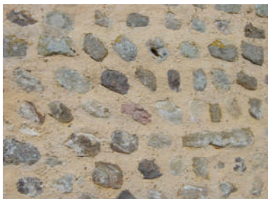
Appareil de petites pierres carrées du XI e siècle
