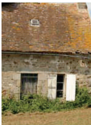
Fenêtre à 6 carreaux et ses volets traditionnels à lames verticales et barres horizontales (barres vues volets fermés) dans une maison rurale du XIX ème .
