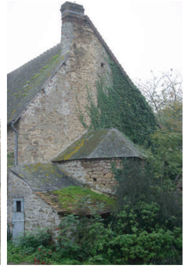
Four à pain couvert en ardoises à deux pentes à La Buretière, Saint-Léonard-des-Bois
