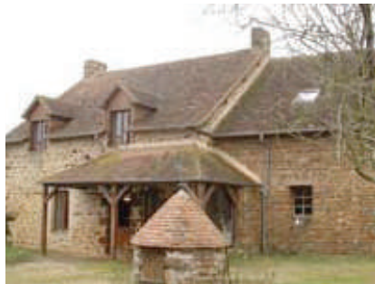
Prolongation de toiture à l'aplomb de portes cochères
