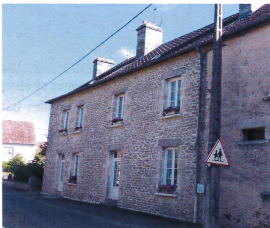
Linteau en granite
