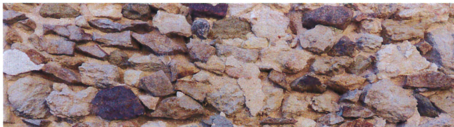
Exemple de murs de façade du bourg ancien
